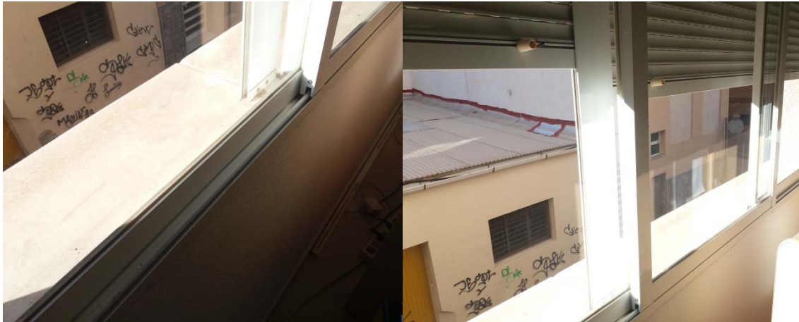
Imagen 3. Carpintería metálica con vidrio monolítico
