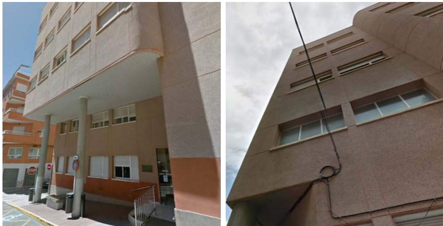
Imagen 2. Fachada paneles de hormigón prefabricado
